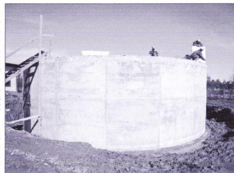
Dzeramā ūdens rezervuāra būvniecība O. Kalpaka ielā.
